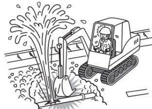
工事場内でガス管の埋設工事中、バックホーの操作をあまり、地中の水道管を破損してしまいました。
